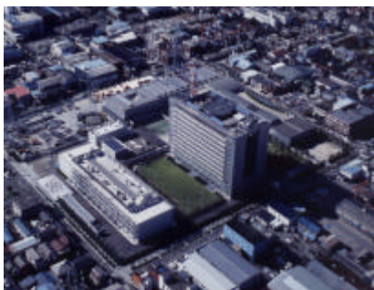
図1 技術開発センターの全景
