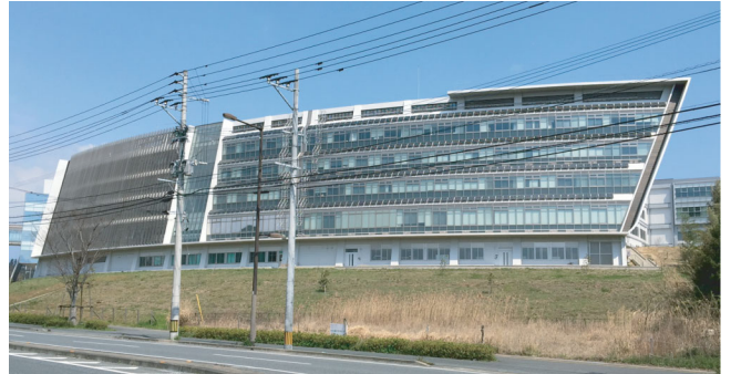
図-1 次世代燃料電池産学連携研究センター棟（右半分）
