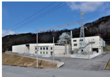
岡山県真庭市 真庭バイオマス発電事業 地域関係者の連携の下、発電事業の新会社が設立。平成 27 年度 4 月より運転開始し、バイオマス発電事業を推進中。燃料収集・供給体制等の整備も促進され、燃焼灰活用の検討も開始。
